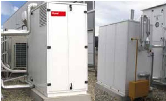
Slim AC avec chaudière gaz à condensation UltraGas® 150 installée sur le toit de l'imprimerie Baltazar à Koprivnica (Croatie).
