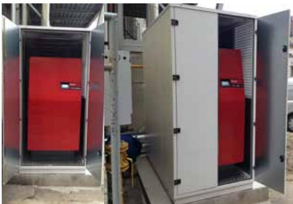
Slim AC avec chaudière gaz à condensation UltraGas® 250 chauffant un bâtiment de bureaux à Bjelovar (Croatie)
